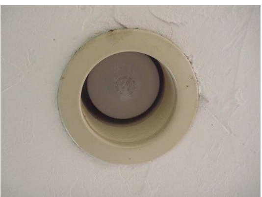
照明全体（ダウンライト）
