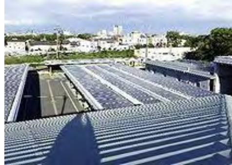
市有施設の屋根貸し （5施設、設置容量合計789.17kW）
