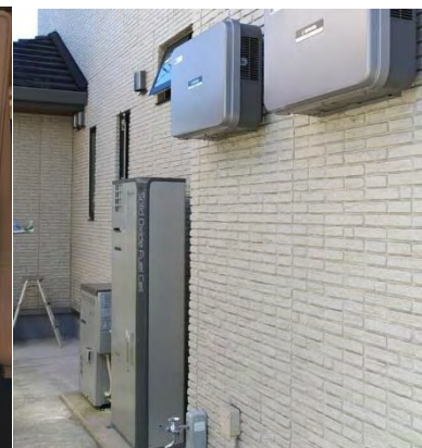
家庭用燃料電池システム(奥側) 太陽光発電のパワーコンディショナー(手前)
