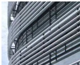
東・南東面の大型 水平ルーバー
